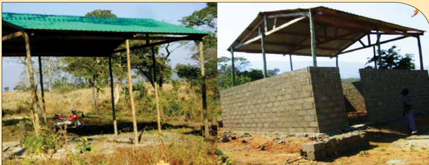
Centro de agregação em Chirodzo, antes e depois da intervenção
